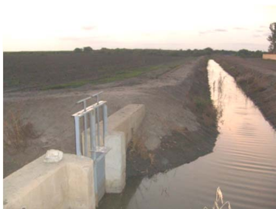
Ici, une partie du système d'irrigation utilisé par la CSS dans une parcelle de canne à Richard-Toll
